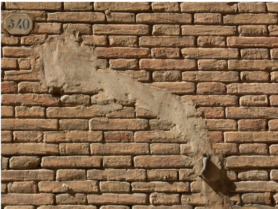
Imagen en la que se aprecian los tres elementos, la espita, la conducción y la placa.
